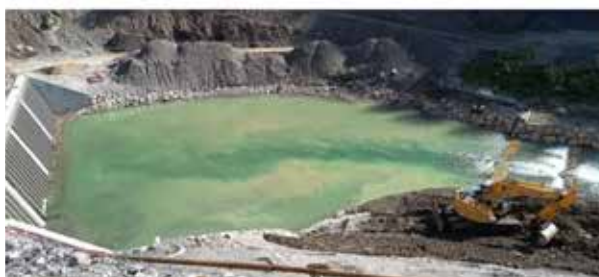
Temeljni izpust z grobo vstopno rešetko 14 dni pred ekskurzijo
