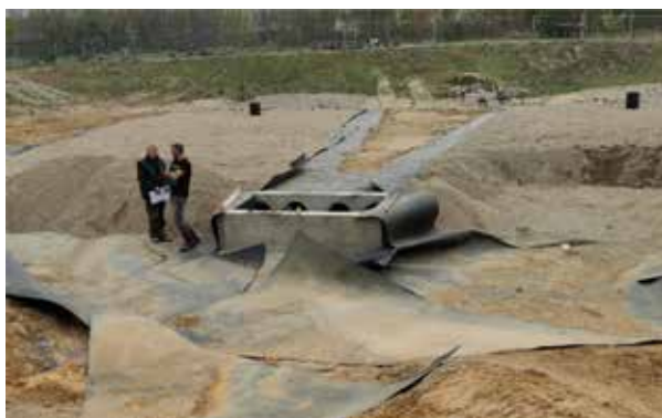
Slika 3: Wolvenberg park med gradnjo filtrnega sistema.
