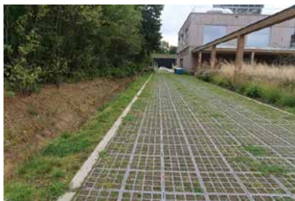
Slika 1: Travne rešetke na intervencijski poti ter zatravljen jarek, za zadrževanje površinskega odtoka (kampus Aquafin).
