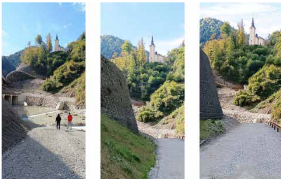
Podslapje suhega zadrževalnika Pod Sušo za učinkovito umiritev vodnega toka dva tedna pred ekskurzijo
