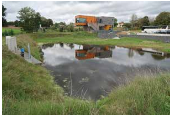
Slika 5: Površinski zadrževalnik padavinskega odtoka v poslovni coni Keiberg-Vossem, namenjen zadrževanju vode pred pripravo za nepitne rabe ali bogatenje podtalnice.
