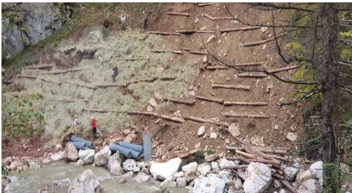
Slika 23: Biotehnična sanacija erozijskih žarišč (foto: G. Ivnik Dujovič, EHO Projekt)
