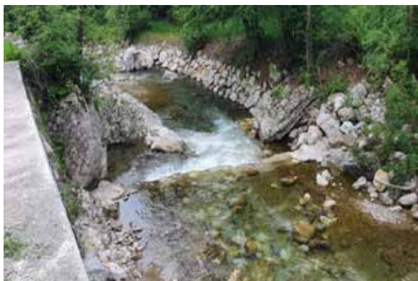
Sliki 24, 25: Sanacija brežin, stabilizacija nivelete (foto: G. Ivnik Dujovič, EHO Projekt)
