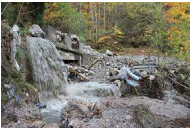
Sliki 10, 11: Izbruh levega pritoka ter poškodbe premostitve prek Tržiške Bistrice gorvodno od prepusta levega pritoka (foto: Občina Tržič)
