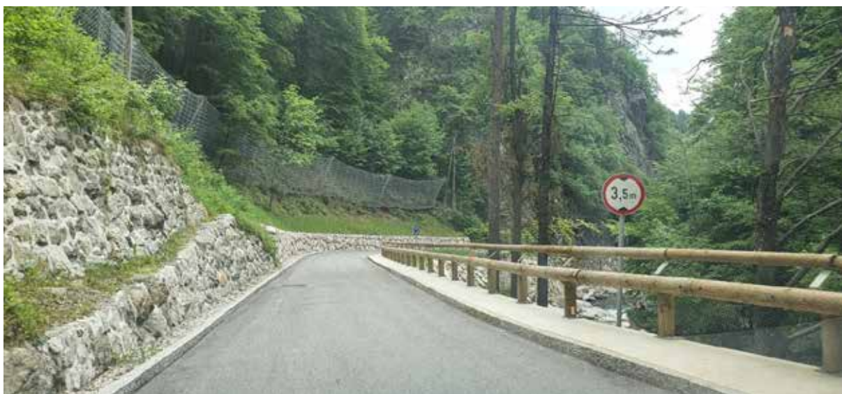
Slika 29: Izvedba podajno lovilnega sistema nad cesto pod skalnimi piramidami (foto: G. Ivnik Dujovič, EHO Projekt)
