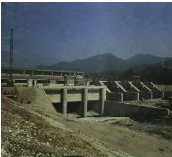
Naslovnica GV št. 7-8 1990: HE Vrbovo v gradnji
