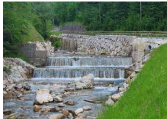
Sliki 24, 25: Sanacija brežin, stabilizacija nivelete (foto: G. Ivnik Dujovič, EHO Projekt)
