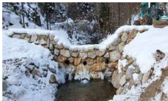
Slika 26: Sanacija brežin, stabilizacija nivelete, rekonstrukcija brvi (foto: G. Ivnik Dujovič, EHO Projekt)
