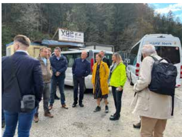
Gradbišče zadrževalnika Zali log; Foto: Yunus Oruc
