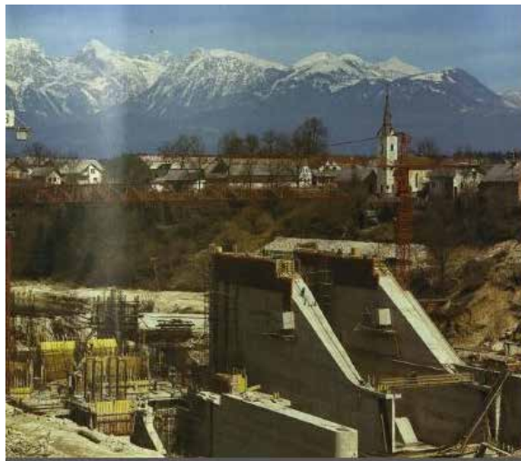
Slika 16: Naslovnica GV št. 7-8 1985: Gradnja HE Mavčiče
