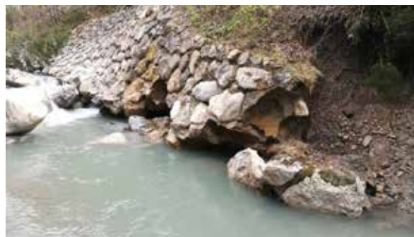
Sliki 14, 15: Podrta lesena brv (foto: Občina Tržič) ter spodkopan LB zid na odseku pod tunelom (foto: G. Ivnik Dujovič, EHO Projekt)
