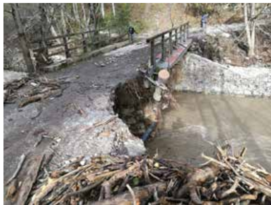
Sliki 10, 11: Izbruh levega pritoka ter poškodbe premostitve prek Tržiške Bistrice gorvodno od prepusta levega pritoka (foto: Občina Tržič)
