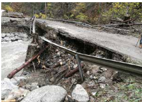
Sliki 8, 9: Poškodovana (levo) in odplavljena (desno) premostitev v Dolini (foto: Občina Tržič)
