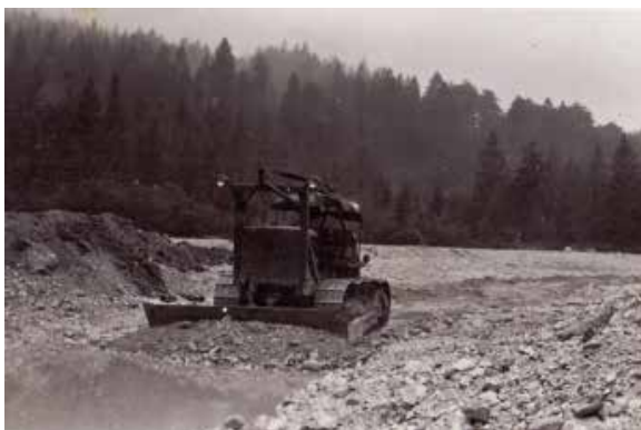
Izkop nove struge
