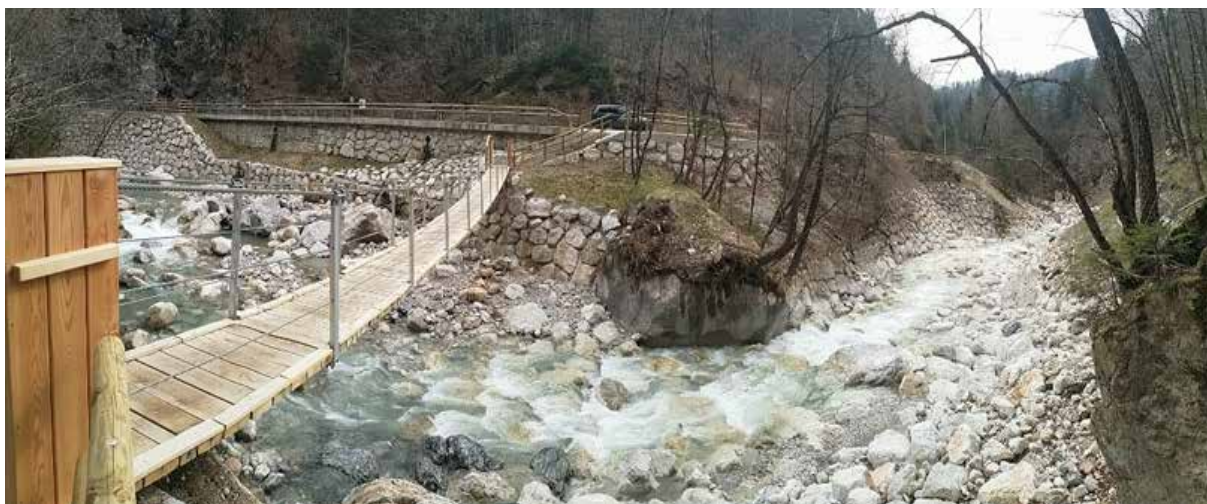
Slika 26: Sanacija brežin, stabilizacija nivelete, rekonstrukcija brvi (foto: G. Ivnik Dujovič, EHO Projekt)
