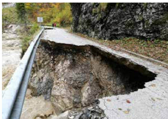
Sliki 10, 11: Izbruh levega pritoka ter poškodbe premostitve prek Tržiške Bistrice gorvodno od prepusta levega pritoka (foto: Občina Tržič)
