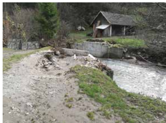
Sliki 8, 9: Poškodovana (levo) in odplavljena (desno) premostitev v Dolini (foto: Občina Tržič)
