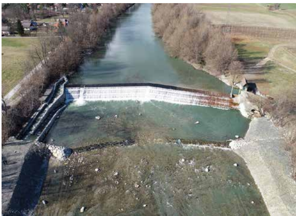
Slika 10 - Izvedena steza za prehod vodnih organizmov
