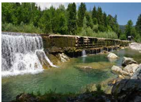
Slika 13 - Pogled na povsem dotrajan Grušoveljski jez
