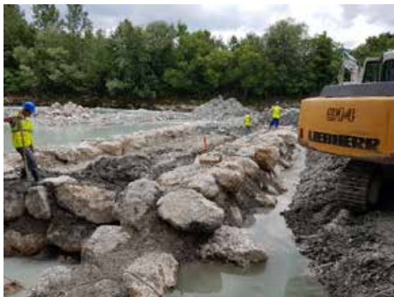
Slika 3: Izvedba vmesnega kamnito-betonskega pragu v telesu drče
