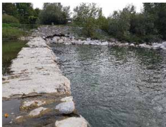
Slika 2: Pogled na odneseno telo drče iz uvodnega pragu
