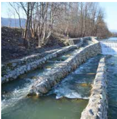
Slika 10 - Izvedena steza za prehod vodnih organizmov
