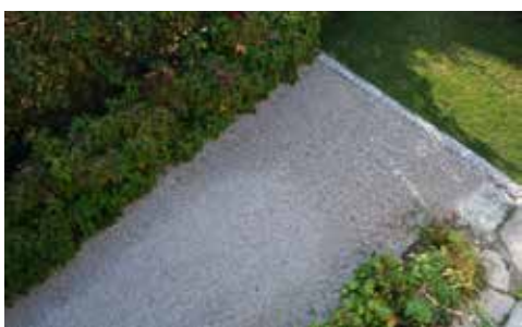
Slika 7: Makadamska dovozna pot (gramoz 8-16mm).
