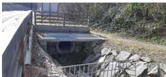
Slika 15: Vtok potoka v kanalizacijo po rekonstrukciji ceste
