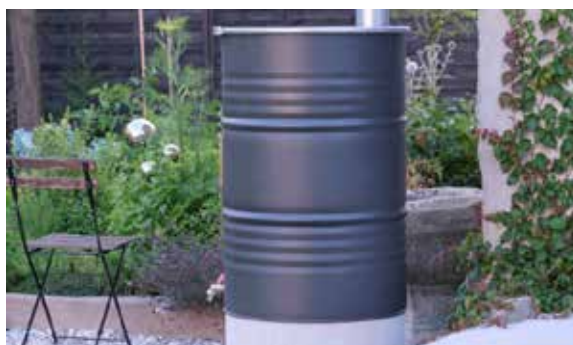
Slika 6: Zalogovnik padavinske vode #naredi sam, izdelan iz navadnega 200-litrskega kovinskega sode za nafto, postavljenega na podstavek iz betonske kanalizacijske cevi.
