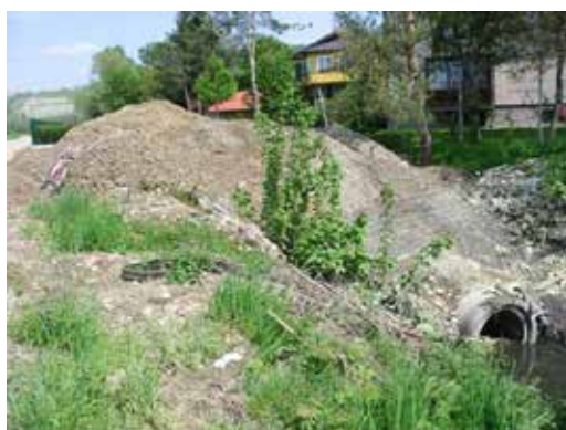
Slika 34: Zožen profil Stražunskega jarka razlog za poplave v letu 2006
