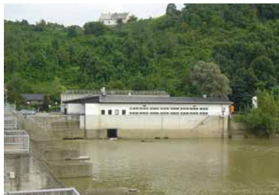
Slika 25: Črpalnica Melje - viden iztok Počehovca
