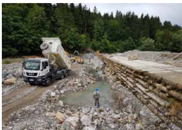
Slika 15 - Pogled na izvedbo KB klina za ojačanje temelja jez
