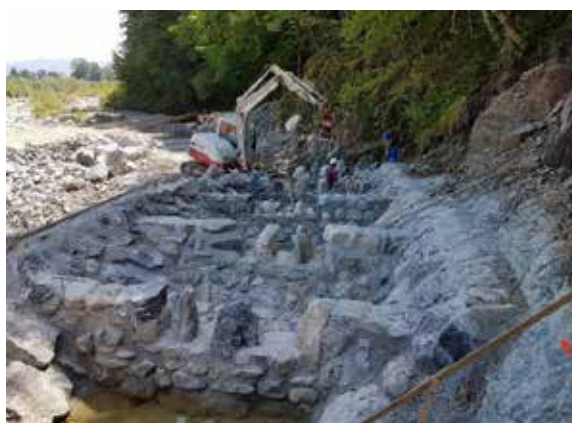
Slika 16 - Izvedba steze za prehod vodnih organizmov
