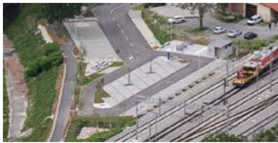
Slika 2: Zeleno parkirišče P+R v Celju, zgrajeno v letu 2019. Asfaltirane so ceste, parkirna mesta za osebna vozila in avtodome so urejena z betonskimi tlakovci z zatravljenimi fugami. Kanalizacijskega sistema ni. Z enega dela parkirišča vode ponikajo na samem mestu, z drugega pa se prek drenaže odvajajo v odprto ponikalnico.
