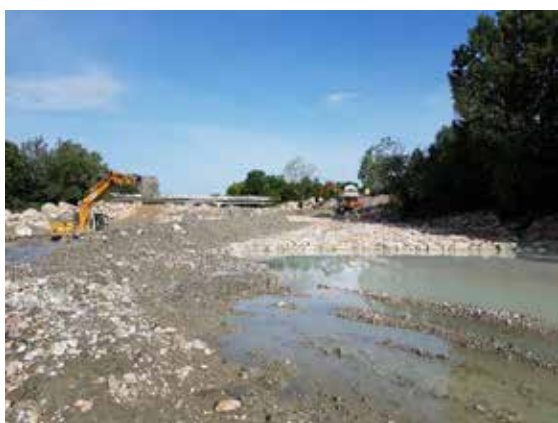
Slika 5: Gorvodni pogled na levo polovico drče med gradnjo
