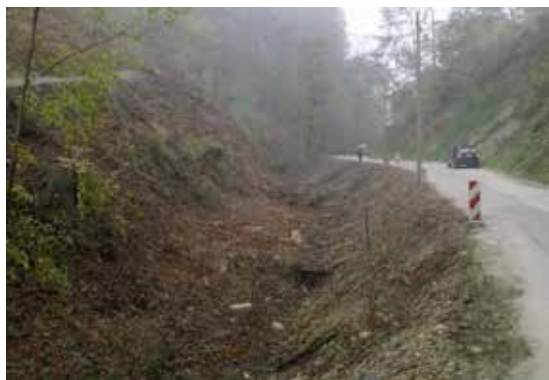
Slika 12: Barbarin potok pred rekonstrukcijo Trubarjeve ceste
