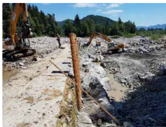
Slika 14 - Izvedba KB klina in nove vertikalne lesene obloge jez
