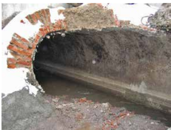
Slika 20: Star opečni kanal v Svetozarevski ulici
