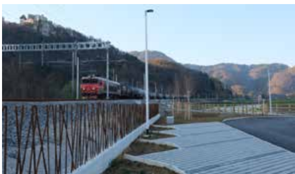
Slika 3: Isto parkirišče, pas trikotnih površin ob robu 45-stopinjske vrste parkirnih mest je uporabljen za odvod, zadrževanje in ponikanje padavinske vode. Prikaz pravkar posajenih sadik.
