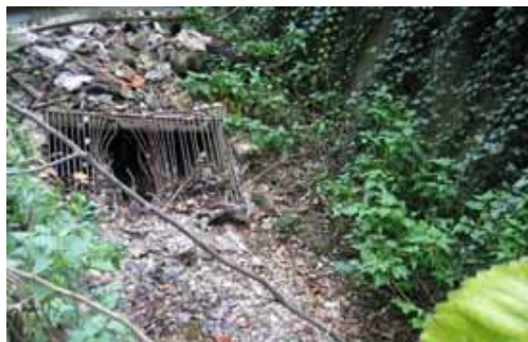
Slika 13: Vtok potoka v kanalizacijo pred rekonstrukcijo ceste
