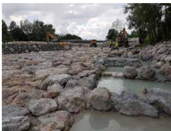
Slika 6: Izvedena leva polovica drče med gradnjo vključno z ribjo stezo
