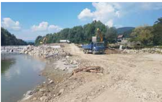
Slika 8 - Izvedba preusmeritvenih nasipov
