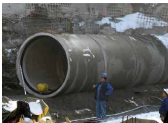
Slika 21: Novi zbiralnik med gradnjo
