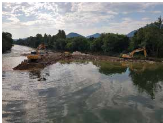
Slika 4: Preusmeritev Savinje z desnega na levi breg
