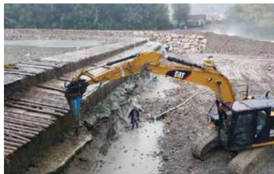
Slika 9 - Pikiranje ostankov temelja jez in izkop gradbene jame za nov temelj jez
