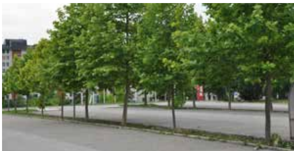
Slika 1: Parkirišče trgovskega in športnega centra v Celju, zgrajeno pred skoraj dvajsetimi leti. Asfaltirane so ceste, parkirna mesta so urejena s tlakovci. V prečni smeri je napravljen strešni naklon, vsa voda se odvaja v vmesni in poglobljeni zeleni pas. Kanalizacijskega sistema ni. Padavinske vode ponikajo.
