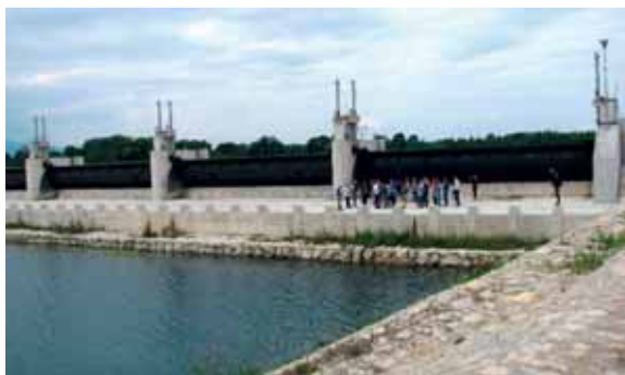
Prelivni objekt za razbremenjevanje visoke vode v gramoznice, ki so namenjene nadomestnim habitatom stojećih voda.
