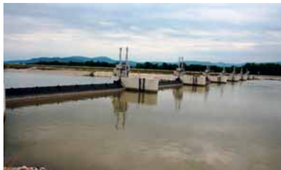
Prelivni objekt za razbremenjevanje visoke vode v gramoznice, ki so namenjene nadomestnim habitatom stojećih voda.
