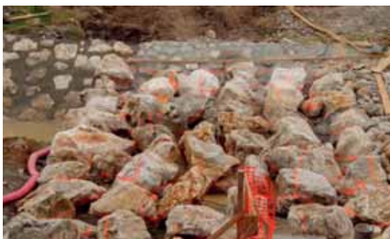
Prikaz vgradnje skal na rampo pred betoniranjem (Foto D. Ciuha)
