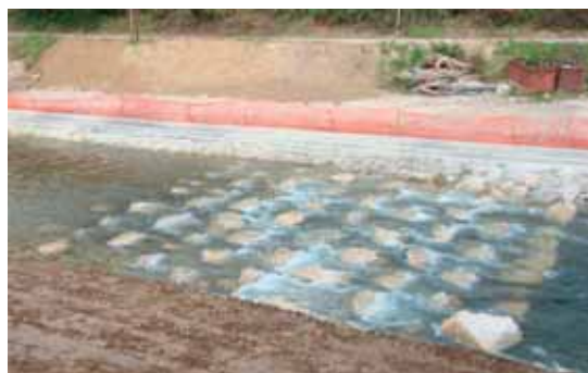
Rampa na Mirni v času delovanja: dimenzije so 15 x 15 m, vzdolžni nagib 1:38. Vidne so izmenično postavljene skale. Pretok v času fotografiranja je okoli 4 m 3 /s. (Foto D. Ciuha)
