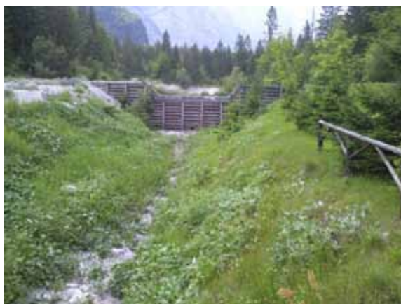
Slika 3: Obstoječa uvajalna pregrada iz železobetonske kašte, polnjene s kamnom
