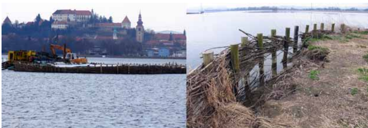
Slika 4: Izdelava Novega otoka na Ptujskem jezeru (levo), erozija na notranji strani Novega otoka (desno, marec 2005, foto D. Denac)
