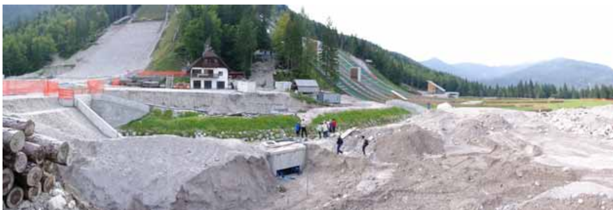
Gradbišče Nordijski center Planica
