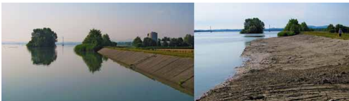
Slika 7: Asfaltna brežina pred ureditvijo (levo), ureditev položne brežine v okviru sanacije brežin (desno, foto M. Trop)
