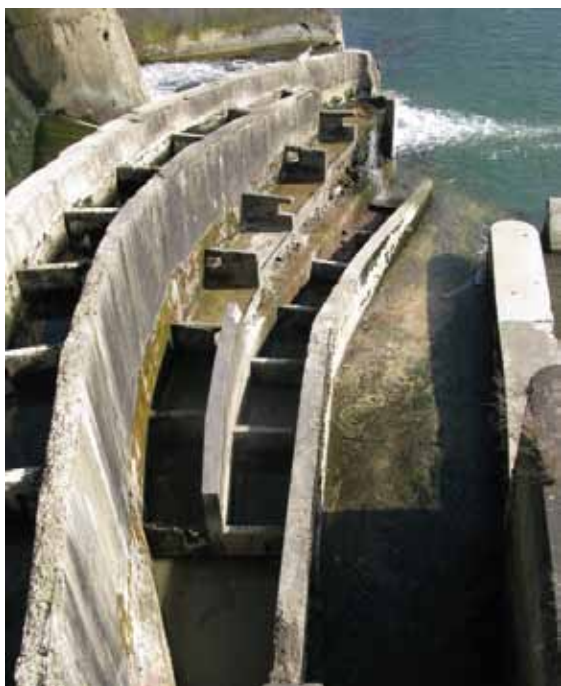
Slika 3: Ribja steza na Fužinah pred poručitvijo in po njej
