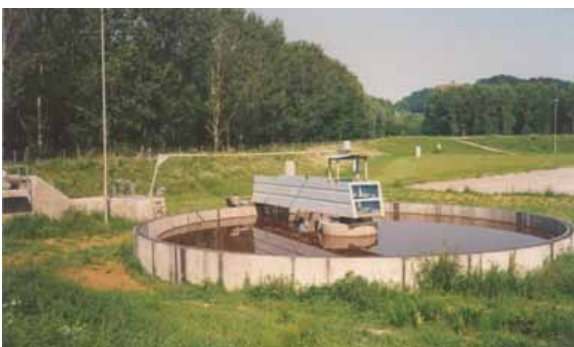
Čiščenje gnojevke naknadni usedalnik na farmi Podgrad
