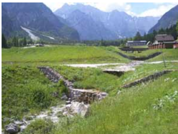
Slika 2: Obstoječa regulacija hudournika Nadiža v območju skakalnic v Planici
