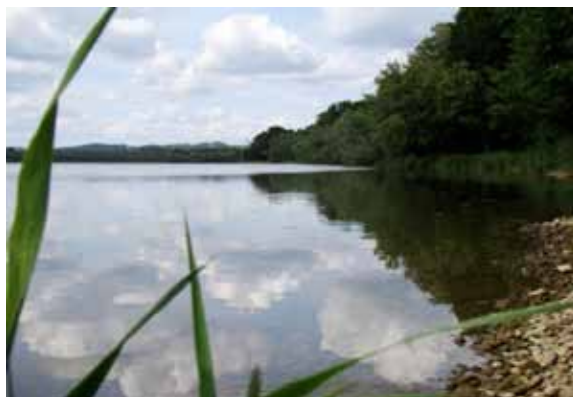
Ledavsko jezero na Ledavi: zgrajeno zaradi poplavalne varnosti Murske Sobote. Danes je akumulacija Natura 2000. Na območju se razvija rekreacija.
