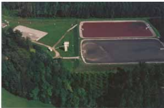
Farma Podgrad z rezervoarjem stabilizirane gnojevke in črpališčem za gnojenje in namakanje 400 ha
