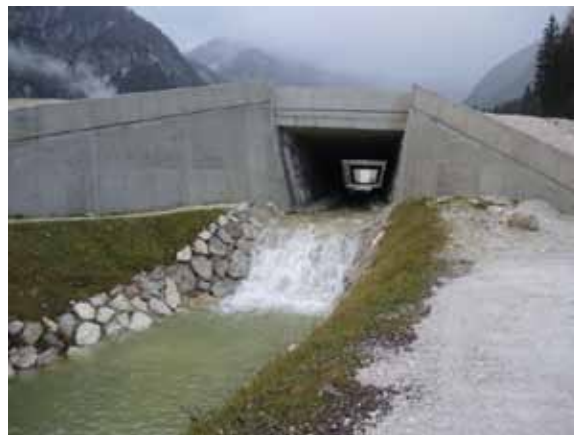
Slika 6: Gorvodni pogled na prekritje s sinusoidalno drčo na zaključku regulacije
