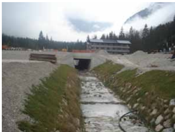
Slika 5: Gorvodni pogled na izvedeno ureditev hudournika Nadiža med iztekom letalnice in drčo nad vtokom pod iztek skakalnic
