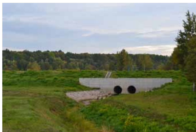
Pogled na pregrado od spodaj
