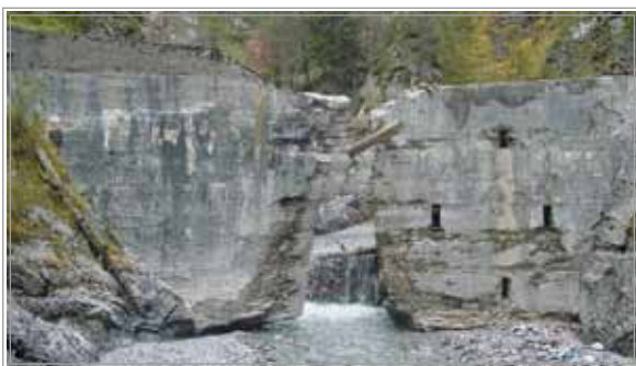
Slika 20: Hudournik Belca v zaledju - po celotni višini erodiran trup zaplavne pregrade, material iz zaplavka je bil postopoma odplavljen (foto arhiv VGP d.d. 2006)
