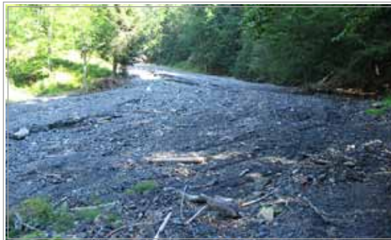
Slika 21: Hudournik Suhelj v zaledju - popolnoma poln zaplavni prostor, plavine so odložene pod relativno strmim naklonom (foto arhiv VGP d.d. 2008)
