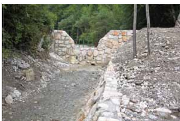
Slika 15: Nidrarska grapa v Podroštu nad Železniki - primer zelo učinkovite zaplavne pregrade z grabljastim prelivom – relativno majhna pregrada, zgrajena v ožjem skalnem profilu, ustvarja zaplavni prostor z volumnom do 5.000 m 3 . Dovozna cesta je speljana prek krila pregrade (foto arhiv VGP d.d. 2009).
