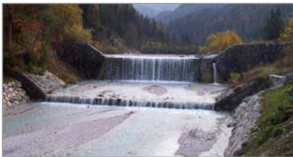
Slika 1: Pišnica v Kranjski Gori - velika zaplavna pregrada iz kamna v betonu (foto arhiv VGP d.d., 2005)
