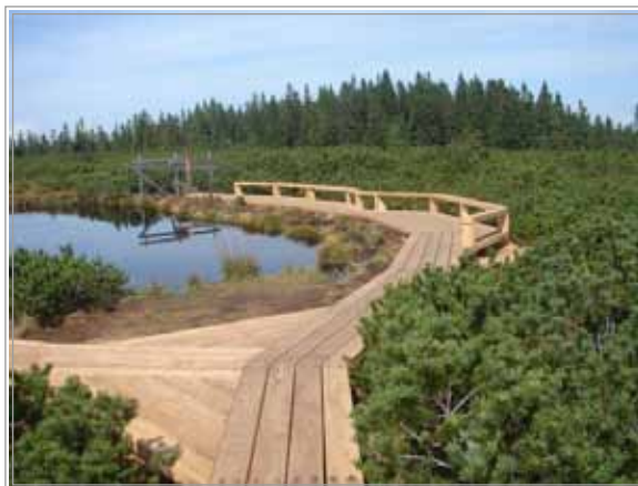
Slika 6: Brunčane poti na Lovrenških jezerih po obnovi
