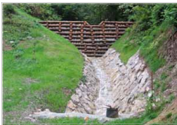
Slika 4: Pritok Čejšnice v Rudnem - zaplavna pregrada iz dvostenskih lesenih kašt, polnjenih s kamnom (foto arhiv VGP d.d. 2010)
