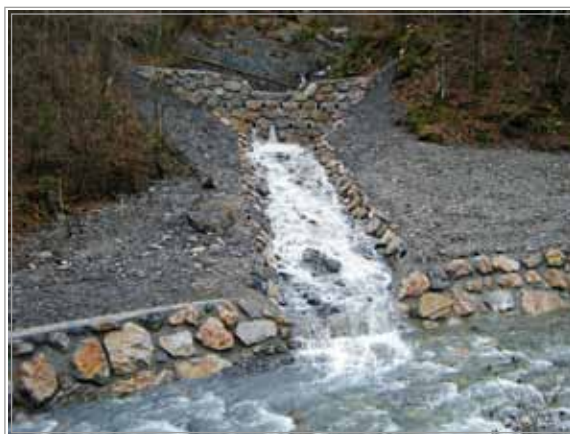
Slika 11: Varžetov graben (pritok zadnje Sore pod Sorico) - zaplavno ustalitvena pregrada, katere zaplavec bo podprl in s tem umiril plazenje pobočij v grapo - zaplavni prostor v prihodnje ne bo prazen (foto arhiv VGP d.d. 2011)
