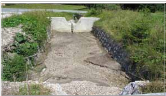
Slika 9: Hudournik Križnica v Podkorenu - obzidan zaplavni usedalnik oziroma peskolov z vtočnim in iztočnim pragom (foto arhiv VGP d.d. 2012)
