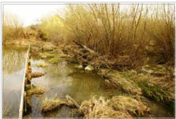
Slika 11: Na pragu visokovodnega preлива, ki že sam po sebi zaradi nevzdrževanja pomeni grožnjo za varnost pregrade, je postavljen fiksni leseni provizorij z namenom dviga obratovalne gladine za potrebe bližnje mHE.
