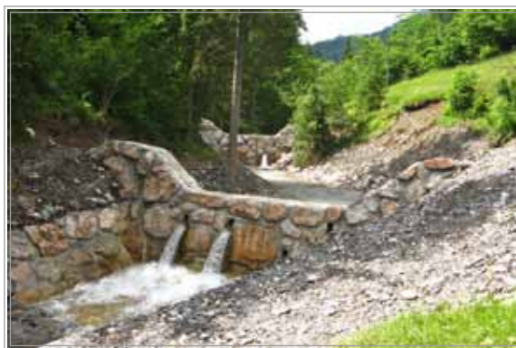
Slika 12: Hudournik Češnjica nad Rudnim - zaplavno ustalitveni pregradi, katerih zaplavka podpirata in s tem umirjata plazenje levega pobočja v strugo - zaplavni prostora v prihodnje nista predvidena za praznjenje (foto arhiv VGP d.d. 2010)
