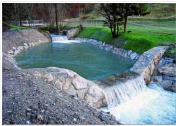
Slika 8: Hudournik Selnica nad vasjo Selce pri Železnikih - obzidan zaplavni usedalnik z vtočnim in iztočnim pragom (foto arhiv VGP d.d. 2010)
