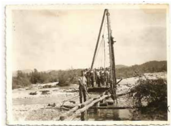
Zabijanje pilotov za bodočo vodilno zgradbo
