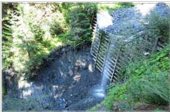
Slika 18: Hudournik Suhelj v zaledju - spodkopana zaplavna pregrada iz armiranobetonskih kašt, polnjenih s kamnom (pregrada bo predvidoma sanirana v letu 2013) (foto arhiv VGP d.d. 2011)
