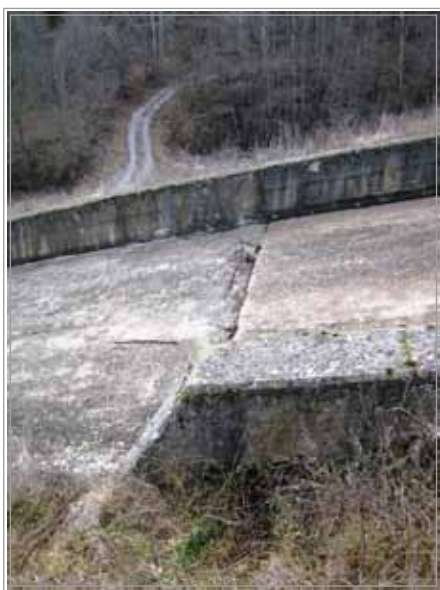
Slika 16: Poškodbe betonske površine in diferenčni posedki konstrukcijskih stikov na prelivni drči visokovodnega preliwa
