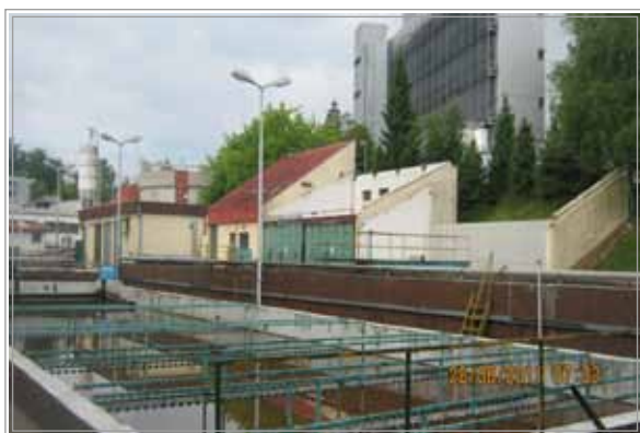
foto iz časa gradnje: rušenje upravnega objekta
