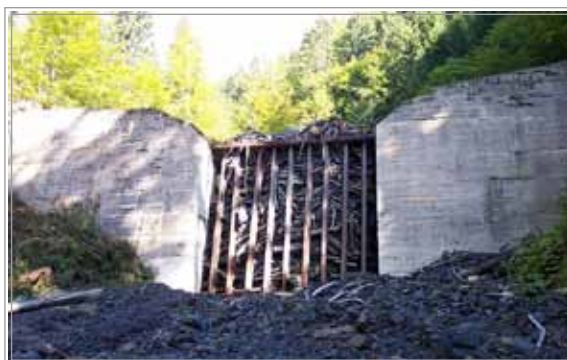
Slika 22: Hudournik Suhelj v zaledju - popolnoma poln zaplavni prostor velike grabljaste zaplavne pregrade (praznjenje je predvideno v letu 2013) (foto arhiv VGP d.d. 2008)
