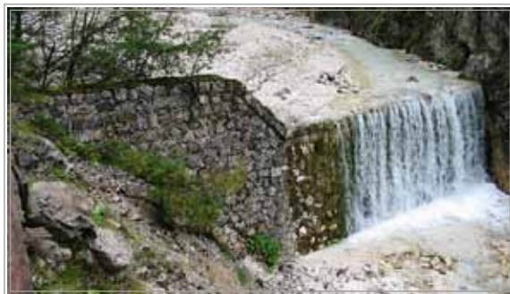
Slika 10: Hudournik Martuljek - zaplavna pregrada na iztoku soteske izpod spodnjega Martuljskega slapu – stara pregrada leži na zavarovanem območju, do nje pa tudi ni ustreznega dovoza, zato ni predvidena za praznjenje (foto arhiv VGP d.d. 2007)
