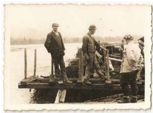
Izdelava vodilne zgradbe iz fašinskih tonjač
