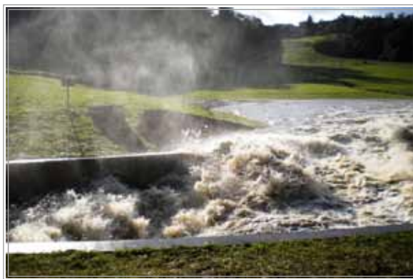
Slika 12: Primer neustrezne zasnove disipacijskega objekta na visokovodnem izpustu – posledica je pojav retrogradne erozije nožice pregrade že v normalnih obratovalnih razmerah.
