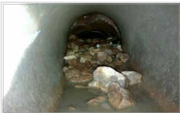
Slika 17: Posedla cev drenážnega sistema
