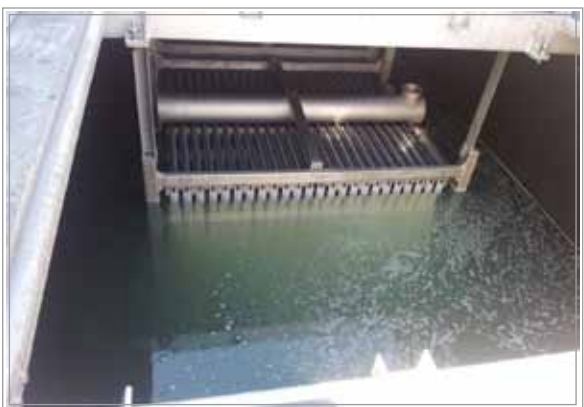
Iz časa gradnje: montaža membran
