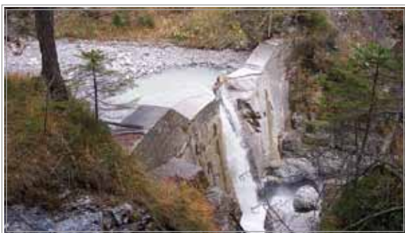
Slika 19: Hudournik Belca v zaledju - po celotni višini erodiran trup zaplavne pregrade (foto arhiv VGP d.d. 2006)
