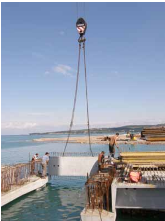
Slika 26: Montaža predfabriciranih elementov
