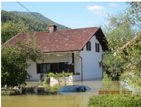
Slika 26: Podtabor – poleg objekta je poplavljen tudi avto
