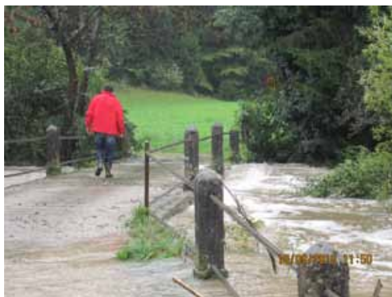
Slika 4: Poddimenzionirana premostitev čez Rašico v Ponikvah – voda je dosegla zgornji rob konstrukcije (18.sept.)
