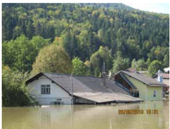
Slika 24: Podtabor – objekt, poplavljen do podstrešja
