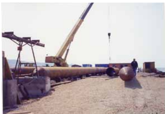
Slika 20: Priprava jeklenih pilotov
