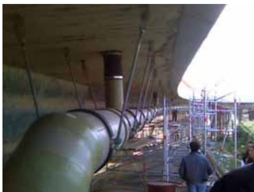
Slika 12. Kačenje sabirne cevi na betonskom delu mosta Gazela.
