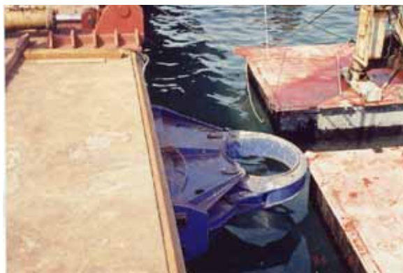
Slika 21: Vodilo za zabijanje pilotov
