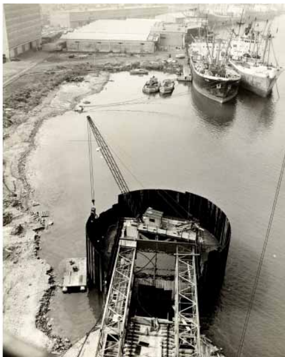
Slika 15: Vež 5 – celična zagatna pregrada
