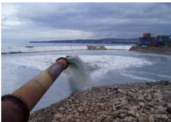
Slika 4: Odlaganje izkopanega materiala morskega dna v pripravljeno kaseto
