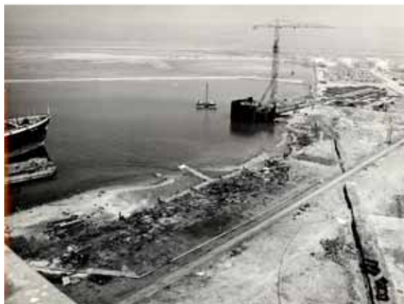
Slika 13: Vez 5 – celična zagatna pregrada
