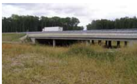
Slika 2: Nizek viadukt prek Črneca na avtocesti Beltinci-Lendava poleg potoka preči še dobršen del kopnega in omogoča prehod različnim živalim. Foto: M. Adamič
