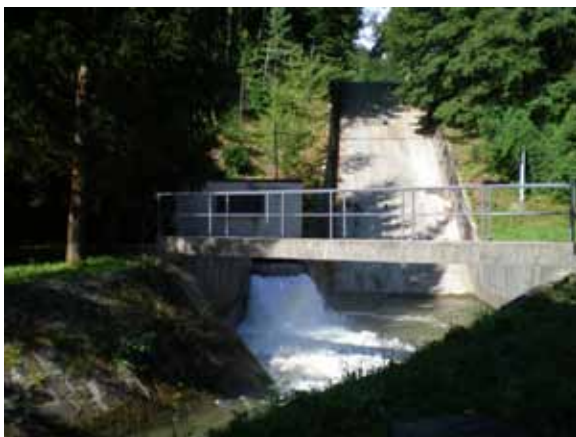
Slika 6. Ozračeni iztok vode iz Mole z varnostnim prelivnim objektom
