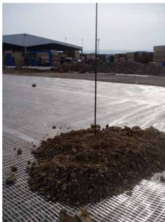
Slika 7: Vertikalne drenaže, plastične armaturne mreže, posedalne plošče
