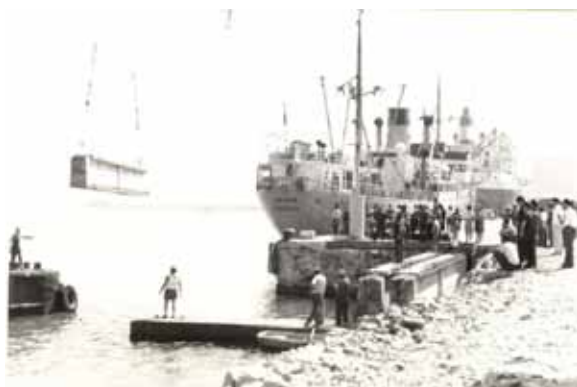
Slika 10: Vez 1A – obala na temeljnih slopih z montažno prekladno konstrukcijo
