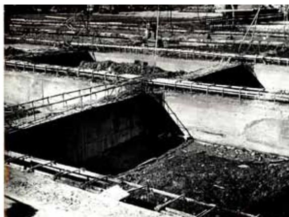
Sliki 16, 17: Veža 8, 9 – graditev obalne konstrukcije s kopnega – zabijanje jeklenih pilotov
