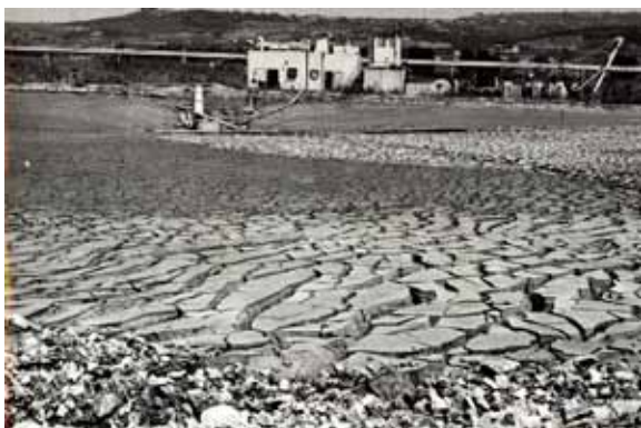
Slika 6: Osuševanje izkopanega materiala na površine pomolov
