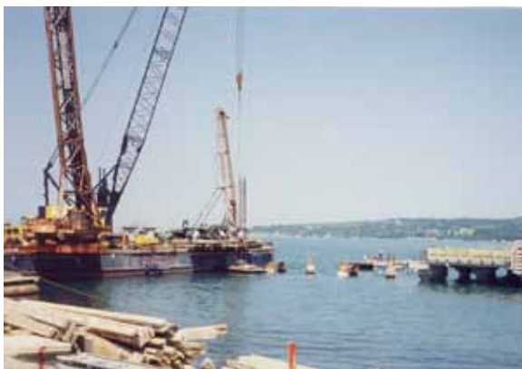
Slika 25: Zaporedje montažnih del pri načinu graditve z morja
