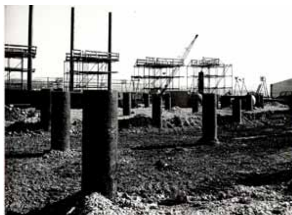
Sliki 16, 17: Veža 8, 9 – graditev obalne konstrukcije s kopnega – zabijanje jeklenih pilotov
