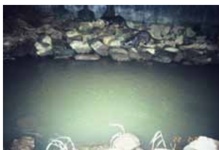
Slika 3: Most s polico, zložena iz skal in večjih kamnov. Fotopast je ujela dve vidri na poti pod mostom. Foto: Arhiv projekta LIFE AQUALUTRA
