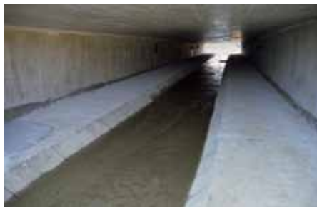
Slika 1: Podhod s policami za prehajanje vidre in drugih živali, urejen pod železniško postajo na Ho-došu, je dolg 45 metrov. Police so široke 100 cm. Vidra jih je uporabila takoj, ko je bil podhod zgrajen. Foto: M.H.A
