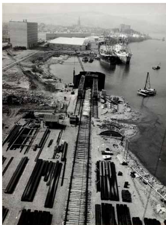
Slika 14: Vez 5 – celična zagatna pregrada
