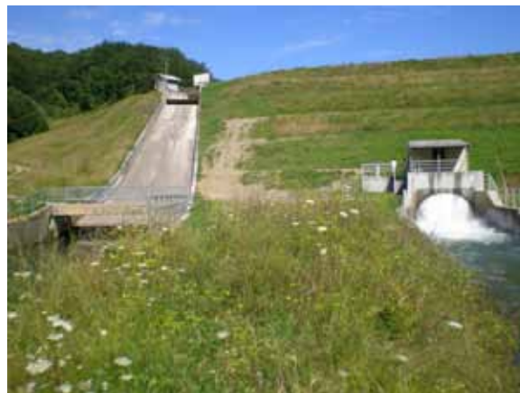
Slika 8. Pregrada akumulacije Klivnik z varnostnim prelivom in ozračenim izpustom vode
