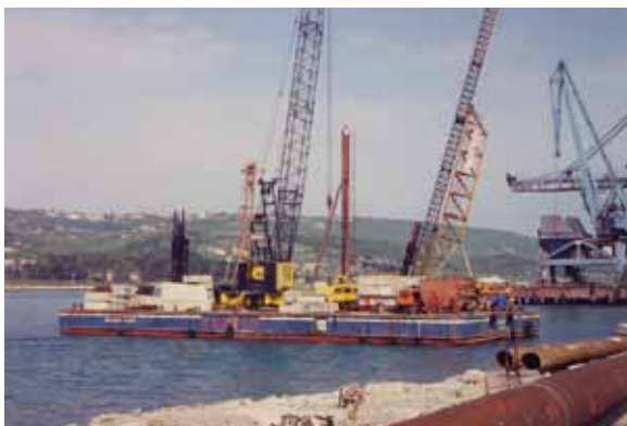
Slika 22: Plovilo z mehanizacijo za zabijanje
