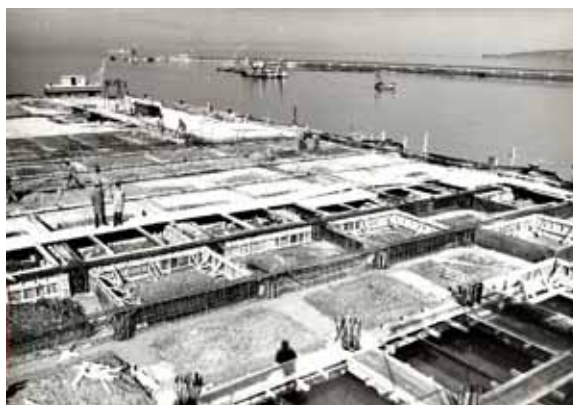
Sliki 18, 19: Veža 8, 9 – graditev obalne konstrukcije s kopnega - betoniranje konstrukcije in izkop
