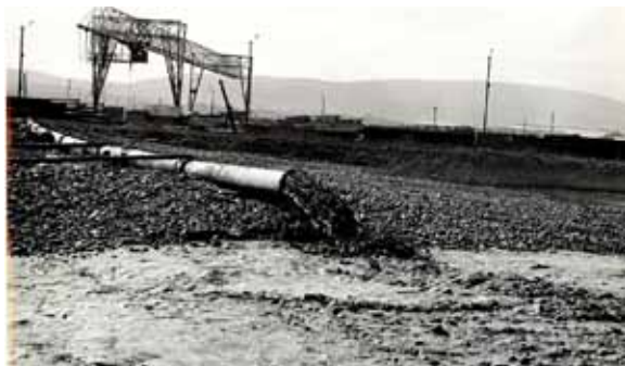
Slika 5: Odlaganje izkopanega materiala
