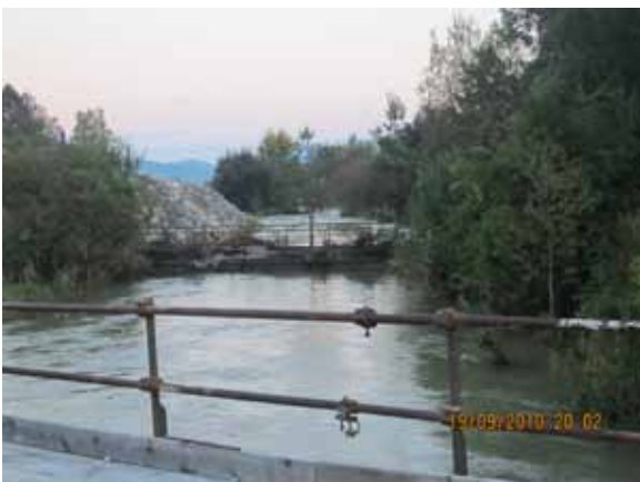
Slika 9: Premostitev čez železnico zajezuje visoke vode Rašice, dolvodno premostitev na dostopni cesti do kamnoloma
