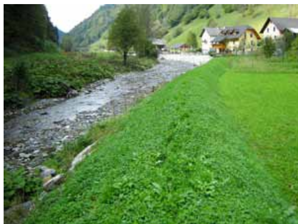
September 2009: sanirano levoobrežno zavarovanje, protipoplavni nasip
