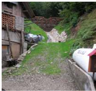
Avrust 2009: zaplavna pregrada na vrhu vršaja, urejena struga do novega prepusta
