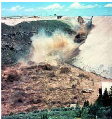
Slika 5: Pregrada oziroma krona je prebita, voda začneja v veliki količini iztekati iz akumulacije. Dolvodno od pregrade nastaja porušitveni val, ki bo še naraščal, dokler ne bo erozija v profilu pregrade dosegla dna doline (matične hribine), oziroma dokler se bo iztočna odprtina širila v globino in/ali v širino.
