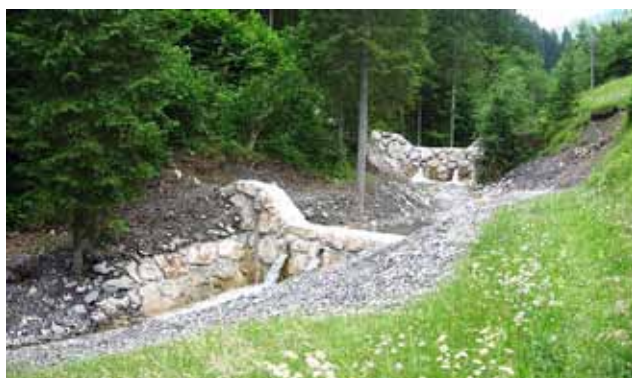
Avgust 2008: Ustaljena struga in sanirana usada z dvema ustaljitveno zaplavnima pregradama, ki tudi umirjata hudournou vodo
