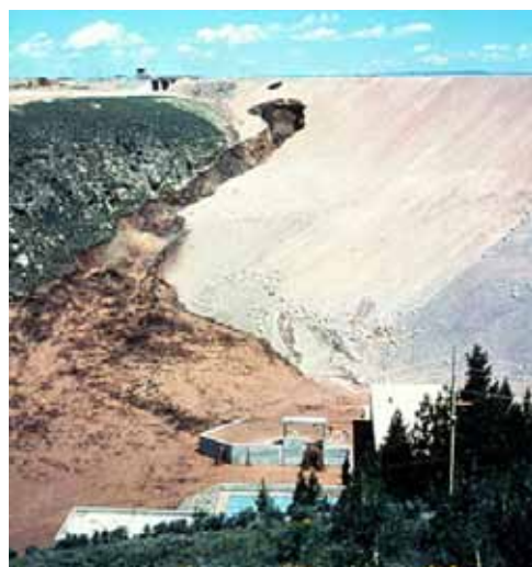
Slika 2: Erozijska znotraj pregrade se na površini kaže kot lomljenje kosov pregradnega telesa, dolvodno od pregrade pa narašča količina pronikle vode, ki teče v obliki murastega toka. Slika pregrade Teton je nastala približno 2 minuti pred zrušitvijo krone. Pika med koncem erozijskega jarka in krono (na desni fotografiji) označuje mesto novega udara.
