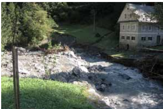
September 2007: erodirane brežine, odnešen most, poplavljen hiša
