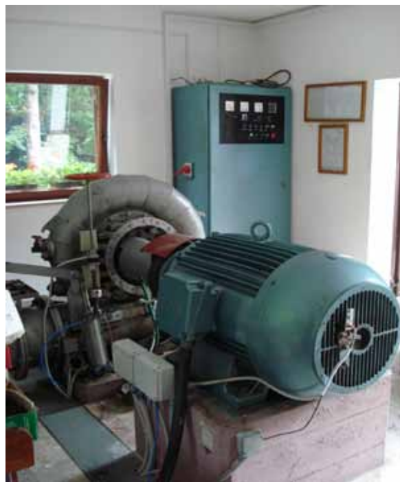
Slika 1: Mala hidroelektrarna »Volaka«
