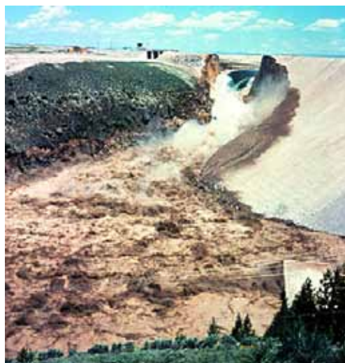
Slika 7: Odprtina na mestu preboja je skoraj že dosegla končne dimenzije, voda odteka z velikim hidravličnim padcem in tvori vodni skok, ki še dodatno krepi erozijo. V tej fazi začne gladina v akumulaciji hitreje upadati in porušitveni val se začne v profilu pregrade zmanjševati.
