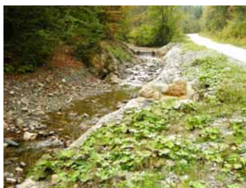
September 2009: sanirana zajeda z levoobrežnim zavarovanjem, uvajalno zaplavni prag na začetku odseka, ki tudi umirja hudourni vodo
