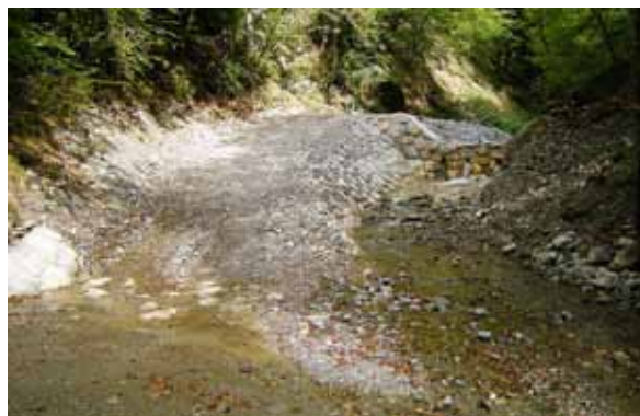
Oktober 2008: zaplavna pregrada in gozdna cesta preko krila, saniran prehod ceste preko struge
