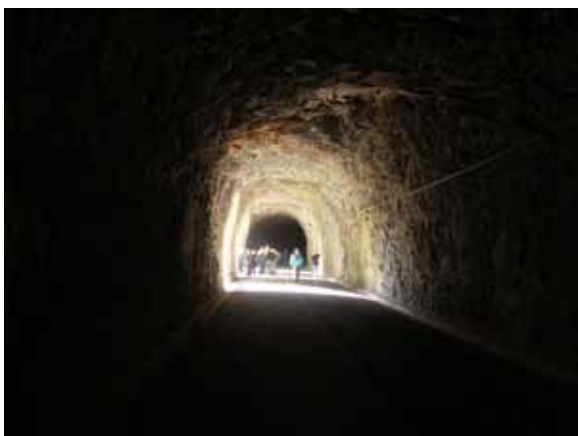
Dostop na spodnji del pregrade
