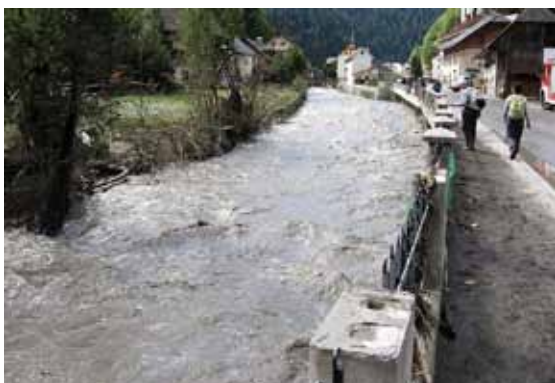
September 2007: zasut pretočni profil, erodirana desna brežina, poplavljeno naselje
