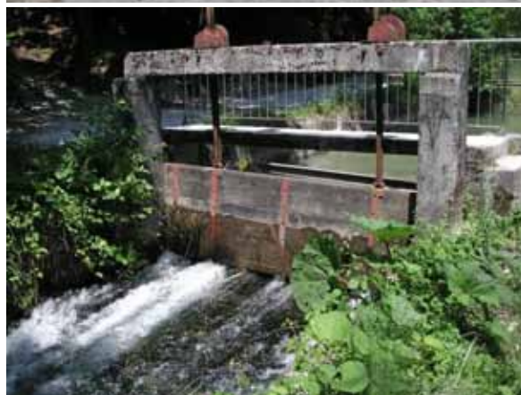
Slika 3: Preliv Homškega jezu z zapornico za talni izpus na sredini v času nizke višine vode dne 21. 8. 2009, (levo) in zapornica, ki regulira količino odvzete vode za mlinščico (desno) (foto: Bogataj, 2009)
