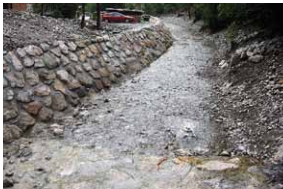
Oktober 2008: sanirano desnoobrežno zavarovanje in ustalitveni pragovi
