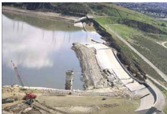
Primer 3: Utekočinjenje (likvefakcija) temelja nasute pregrade ob potresu - Lower San Fernando Dam, ZDA (1971)
