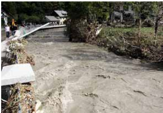
September 2007: zasut pretočni profil, erodirana desna brežina, poplavljeno mesto, uničen zdravstveni dom
