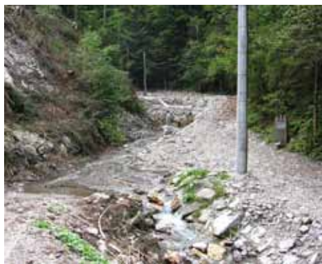
Avgust 2008: sanirana in nadvišana pregrada, očiščena struga in zaplavni prostor
