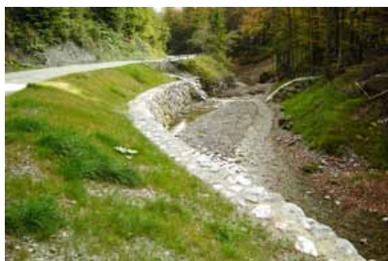
Oktober 2009: sanirana leva brežina, struga ustaljena z ustalitvenim pragom, ki tudi umirja hudournu vodo (pogled dolvodno)
