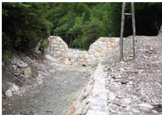
September 2008: zaplavna pregrada pod sotočjem s Štajnpohom
