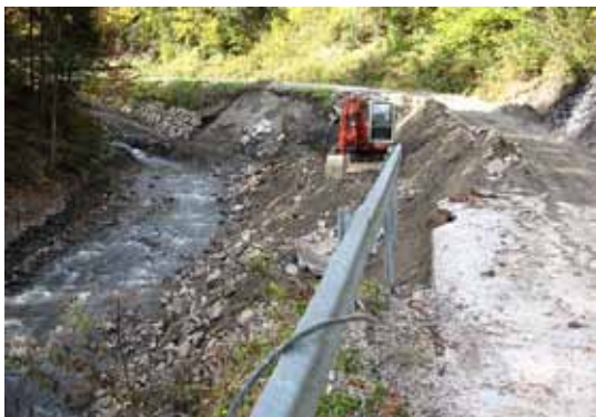
Oktober 2007: močno poglobljena struga in velika zajeda v levoobrežni konkavi, odnešena cesta
