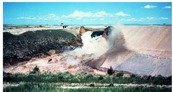
Primer 4: Notranja erozija nasute pregrade; Teton, ZDA (1976)
