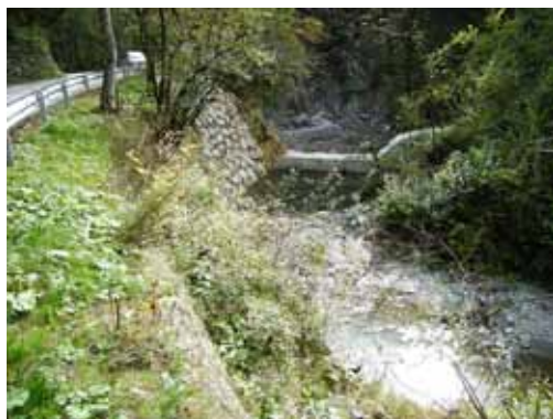
Oktober 2009: zaplavno ustalitvena pregrada na dolvodnem koncu odseka (zaplavek je še prazen), sanirani podporni zidovi reg. ceste (pogled dolvodno)
