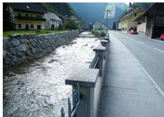
Oktober 2009: očiščena struga, nov desnoobrežni zid
