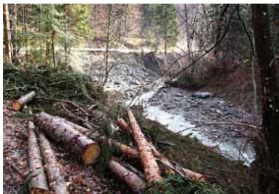
Oktober 2007: močno poglabljena struga in velika zajeda v levoobrežni konkavi, odnešena cesta (pogled dolvodno)
