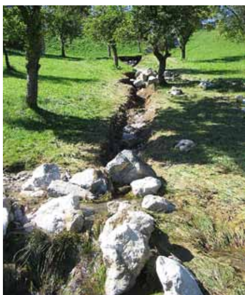
September 2007: močno erodirana struga, odnešeno zavarovanje
