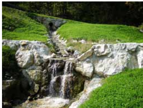
Oktober 2009: sanirana struga in prepust, ustalitveni prag
