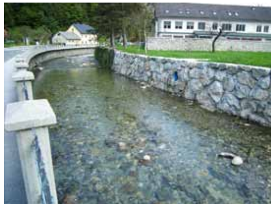
Oktober 2009: očiščena struga, nov db zid ter protipoplavna zidana ograja ob ZD
