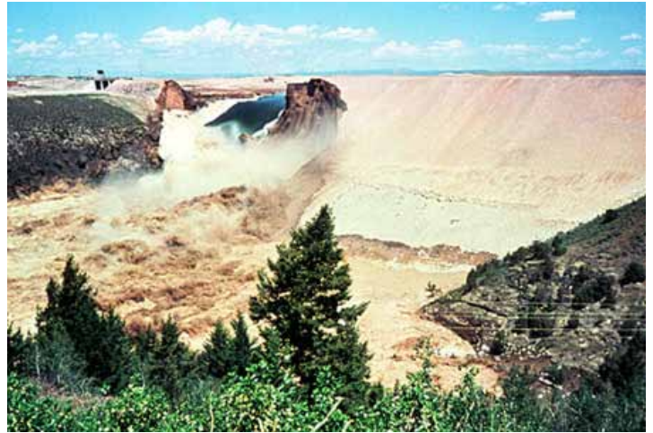
Slika 8: Odprtina ima končno dimenzijo, nivo akumulacije je že bistveno nižji kot ob nastopu preboja, kar pa je odvisno od dimenzij in oblike akumulacije. Akumulacija Teton se je spraznila v približno 5 urah.
