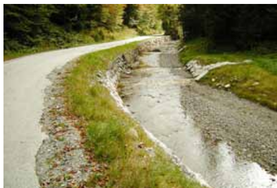
Oktober 2009: sanirana leva brežina, struga ustaljena z ustalitvenimi pragovi (pogled dolvodno)
