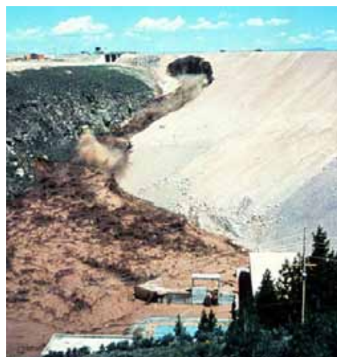
Slika 3: Erozijska napreduje proti kroni, odlomljeni kosi telesa so vedno večji, prav tako hitro narašča količina pronikle vode. Očividci rušenja pregrade Teton so 15 minut pred zrušitvijo krone govorili o odlomih »velikosti viličarja«, 30 sekund pred zrušitvijo krone o »velikosti manjšega tovornjaka«, tik pred zrušenjem pa že o »velikosti hiše«.
