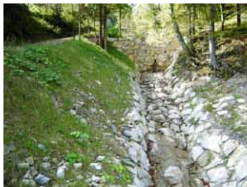
Oktober 2009: zaplavna pregrada na izteku grape, utrjena struga do prepusta
