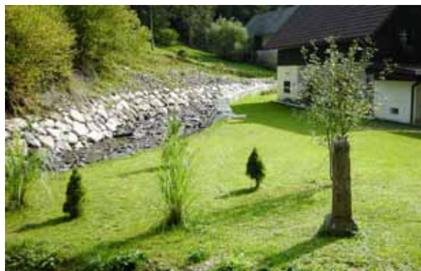
September 2009: sanirana obrežna zavarovanja, saniran usad
