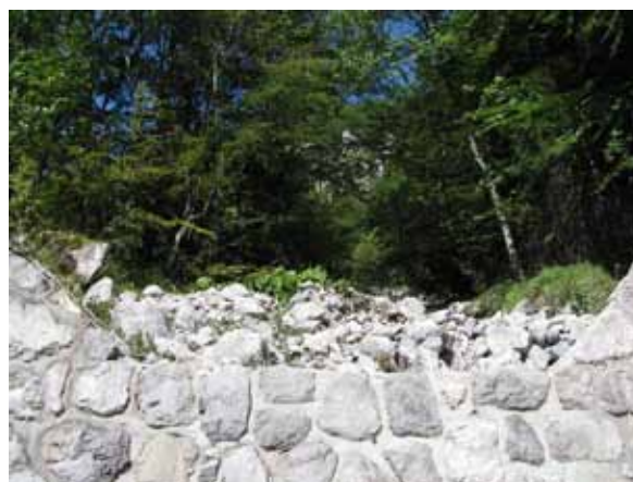
Slika 1: Zapolnjen zaplavec pregrade
