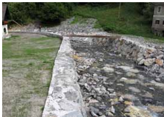
September 2008: sanirani obrežni zidovi in zavarovanja, ustaljeno dno z drčo, saniran usad
