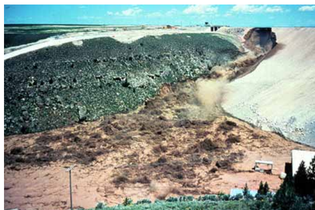
Slika 4: Erozijski kanal notranje erozije je dosegel krono, začenja se rušenje krone in prelivanje, ki je veliko hitrejši proces od notranje erozije.
