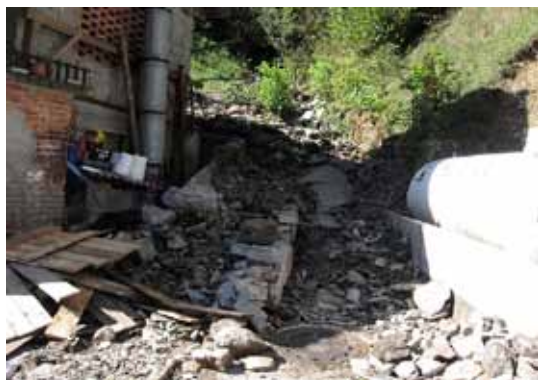
September 2007: razdejanje na vršaju - zamašen prepust, poplavljena in zasuta hiša in cesta, močno erodirana zaledna grapa
