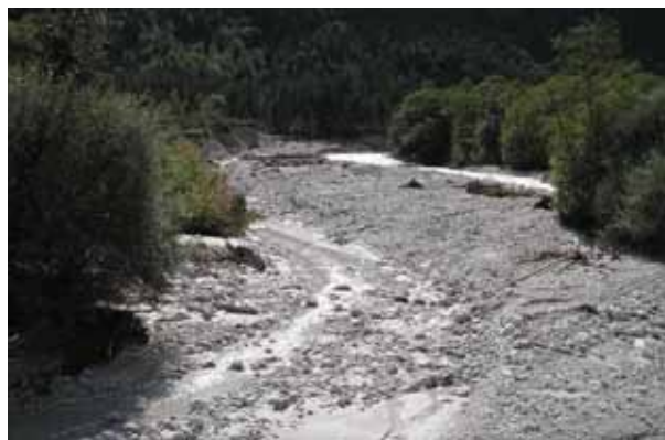
Sava Dolinka – levoobrežna zajeda in odnesena pot dolvodno od mostnega opornika v Gozd Martuljku
