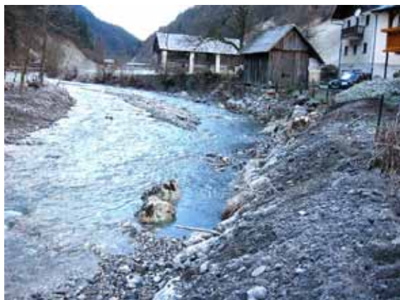
September 2007: močno erodirana levoobrežna konkava, poplavljeni in erozijsko ogroženi objekti, zastajanje nanosov v strugi
