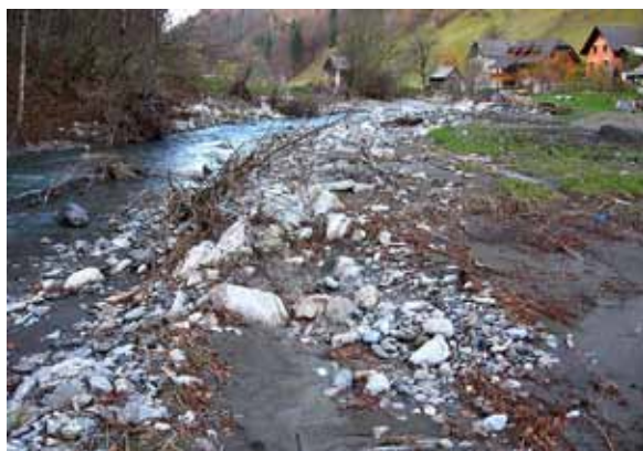
September 2007: razdejana struga, močno erodirane brežine, poplavljeni in erozijsko ogroženi objekti
