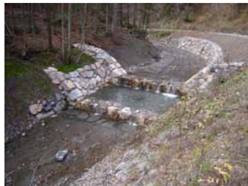
Oktober 2008: sanirana levoobrežna zajeda, ustaljena struga s pragom, ki umirja hudourni vodo
