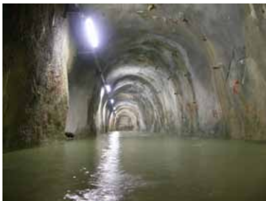
Galerije za odvodnjavanje bokov pregrade
