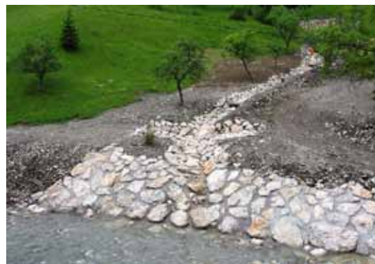
September 2008: urejena struga preko vršaja, manjša zaplavna pregrada na vrhu vršaja, urejeni prehodi preko struge
