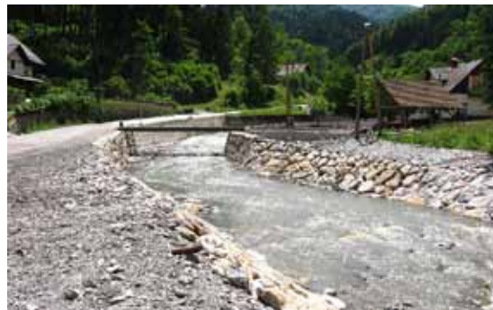
September 2008: sanirani obrežni zidovi in za-varovanja ter mostni oporniki, dno ustaljeno z drčami
