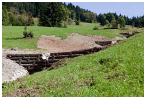
Slika 3: Ureditev jarka s hudourniškimi kanaletami in lesenimi kaštami (avtor Polona Avanzo)
