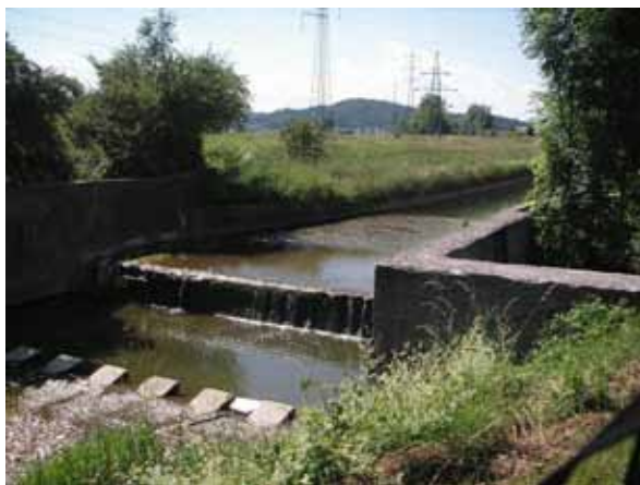
Slika 4: Razbremenilni kanal Pšate na mestu prečkanja struge Homške mlinščice (foto: Bogataj, 13. 6. 2009)
