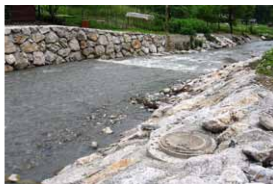
Junij 2008: sanirani obrežni zidovi in zavarovanja, ustalitevna drča varuje prečkanje kanalizacije
