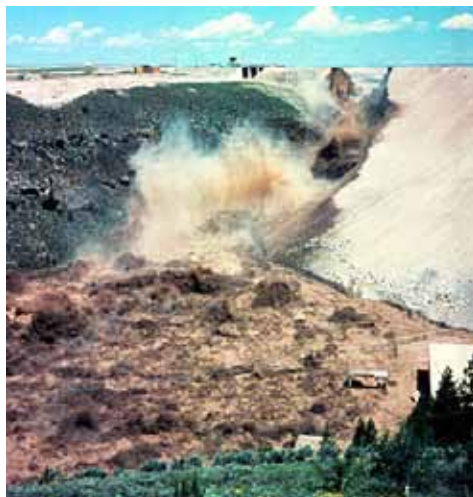
Slika 6: Odprtina na mestu preboja se širi, na modelni pregradi je na levi strani prebojne odprtine vidna črna barva jedra. Pregrada Teton je bila tesnjena s širokim glinenim jedrom in je imela praktično značaj homogene nasute pregrade.
