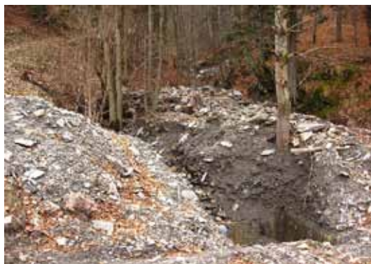
Oktober 2007: na vršaju zasuta cesta in zamašen prepust, močno erodirana zaledna grapa, sproščanje velikih količin plavin
