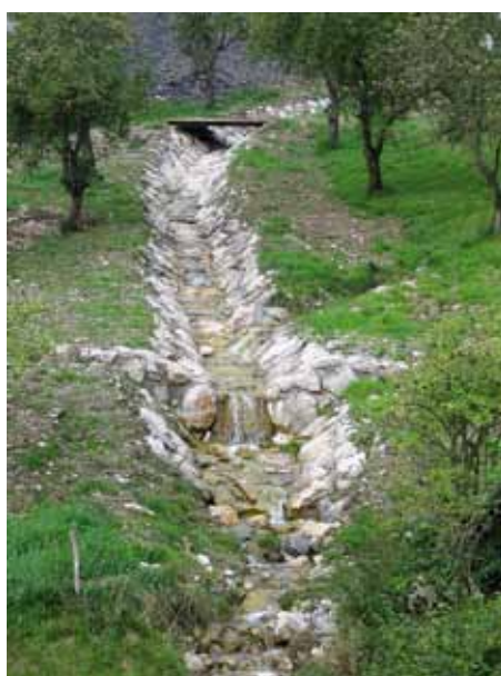
September 2008: sanirano zavarovanje struge in ustalitveni pragovi
