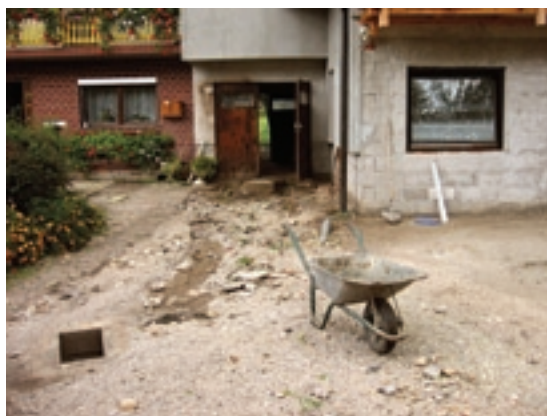
Poškodbe brežin, poplavljen stanovanjski objekt
