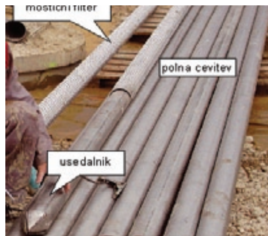
Slika 7: Cevitev vrtine hidrološke postaje za podzemne vode.
