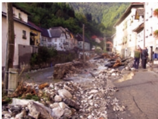
Slika 1: Poškodovan zgornji del osrednjega trga v Kropi (foto: Sodnik, 19.9.2007)
