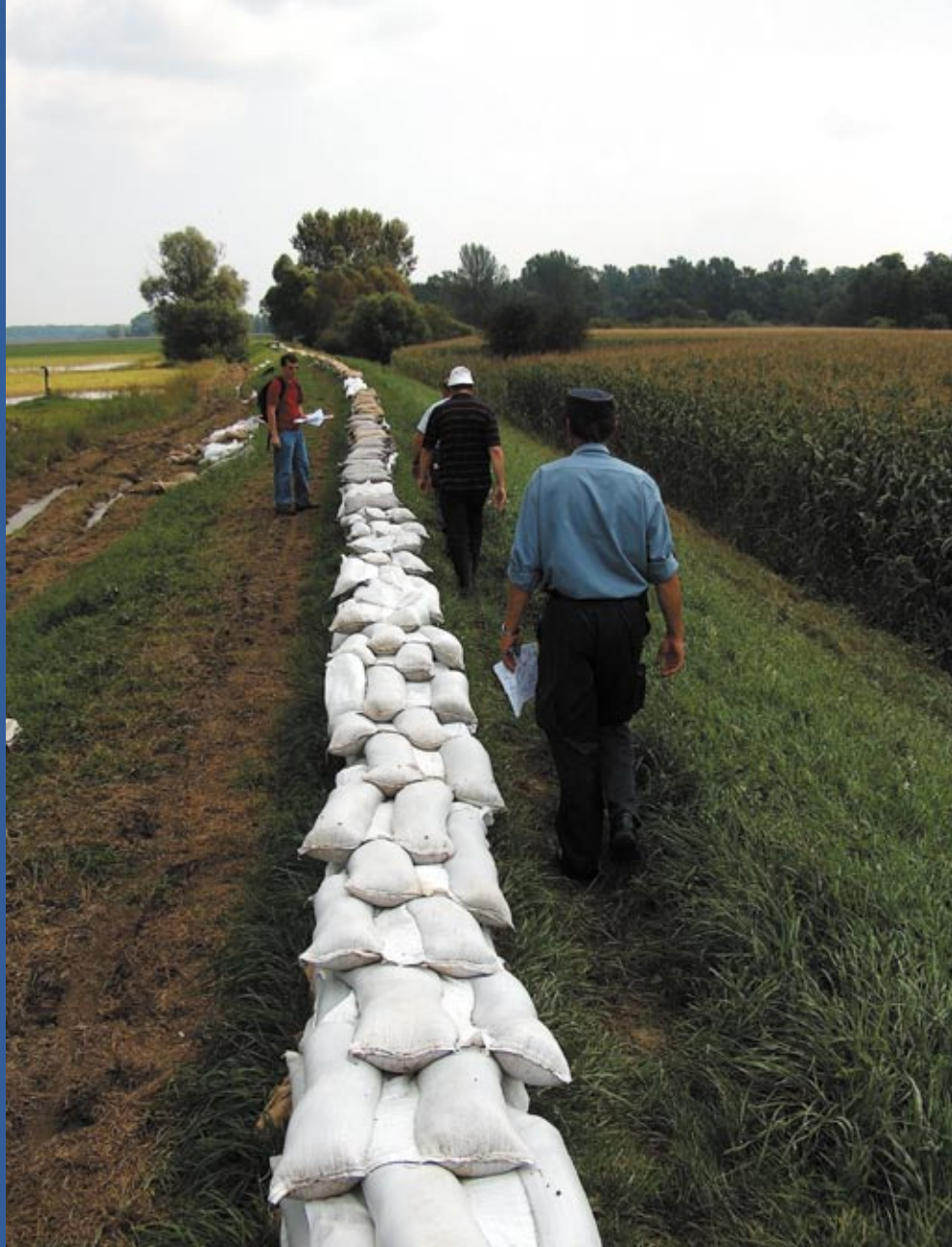
22. in 23.08.2005 so s peskom ročno napolnili in vgradili približno 80.000 vreč
