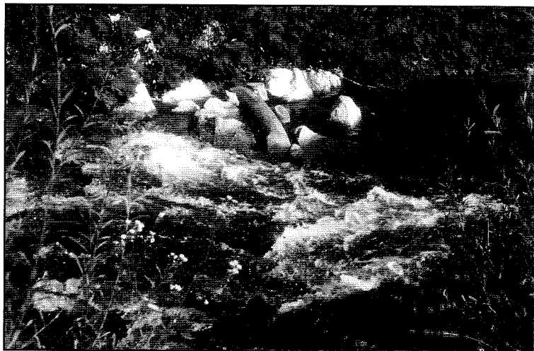
Revitalizacija Jeseniščice - stanje struge l. 1990 (7 let po zgradnji); Foto: Stane Pavlin
