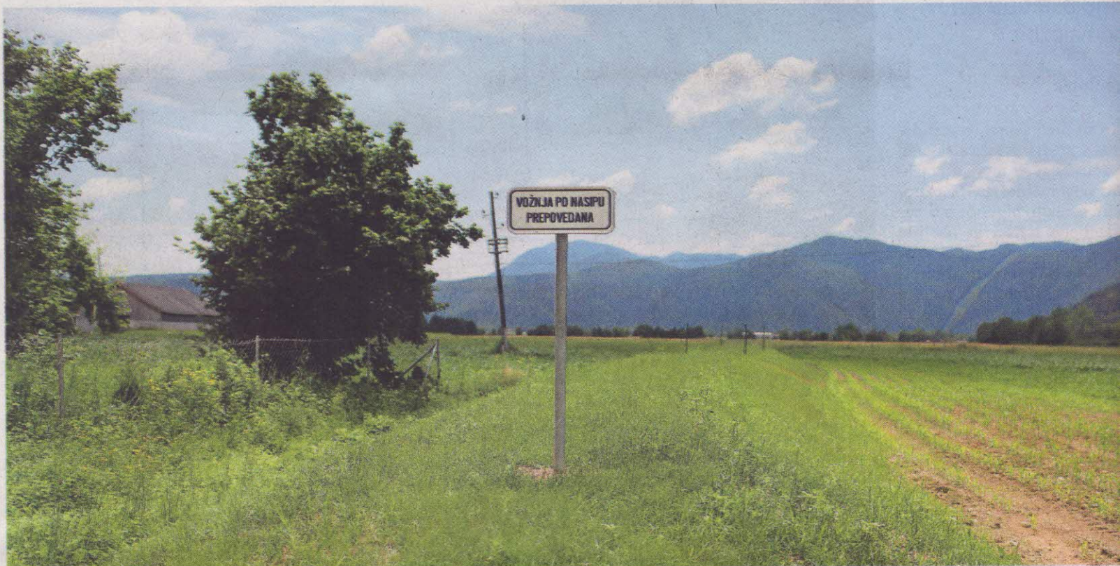
Protipoplavna nasipa pri naseljih Brest in Tomišelj naj bi pred poplavami zaščitila več kot 110 objektov v občini Ig. Bojan Velikonja
